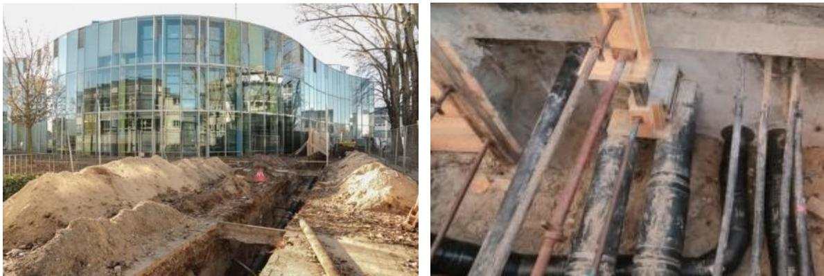
**Abbildung 14** *Bautätigkeit zur Anbindung des Standorts 3 an das Kältenetz – links: Verlegung der zusätzlichen Kaltwassertrasse, rechts: Gebäudeeinführung 19.51*
