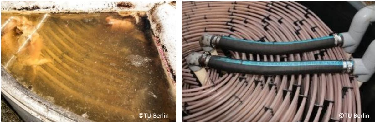
**Abbildung 16** Wärmeübertragerflächen des Eisspeichers vor (links) und nach (rechts) der Reinigung
