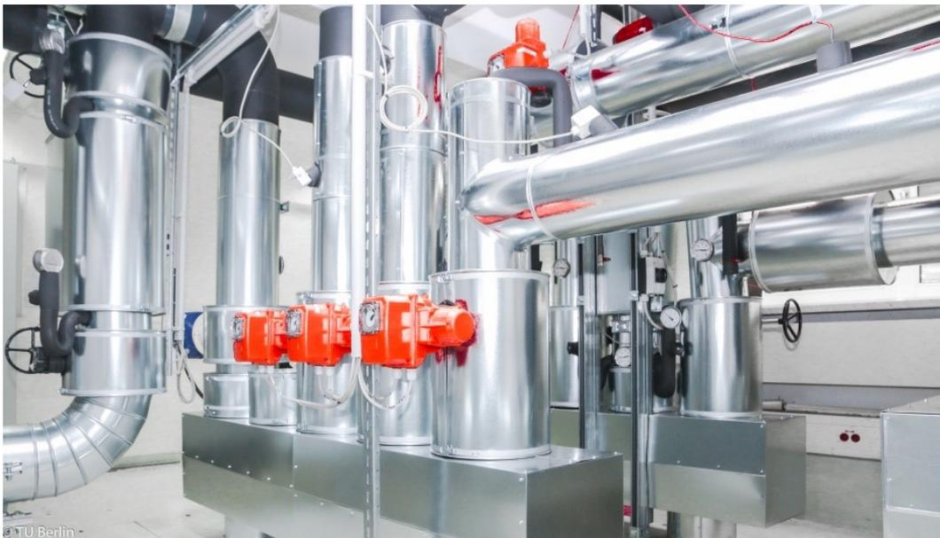
**Abbildung 105 Kälteübergabestation am Kälteerzeugerstandort 1**
