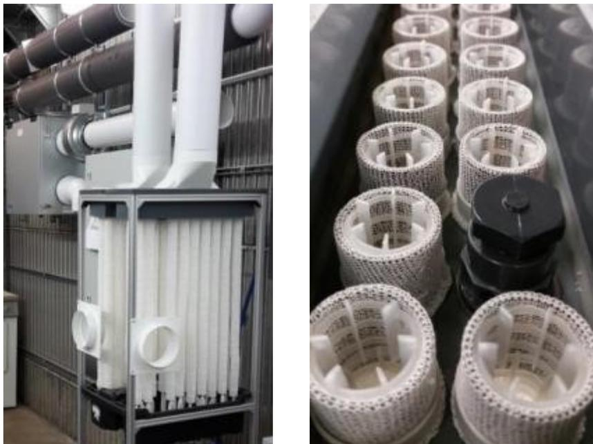
**Abbildung 48** Absorberkolonne (links) mit Soleverteilung (rechts)
