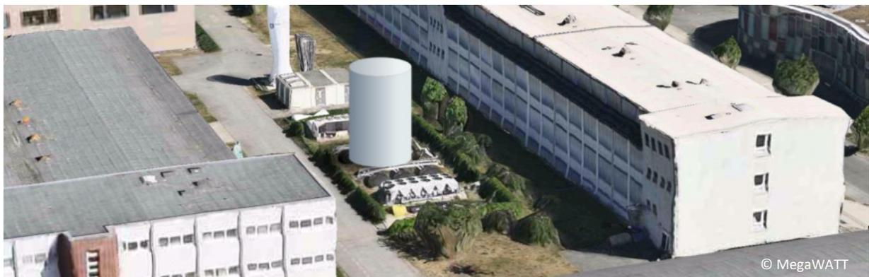
**Abbildung 15** *Rekonstruktion Kaltwasserspeicher mit reduzierter Kapazität*
