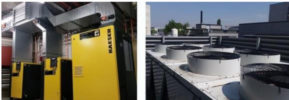
**Abbildung 39** Kompressorstation mit Abluftkanal links; Rückkühlwerk der Kältemaschinen Standort 3 rechts
