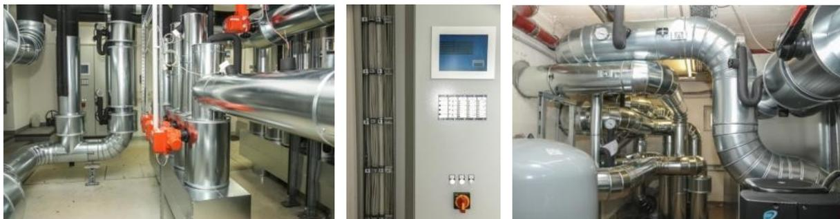
**Abbildung 17** Neu errichtete Kälteverteilung und Informationsschwerpunkt 1 bei Abschluss der Umsetzungsphase am Standort 1; ©TU Berlin
